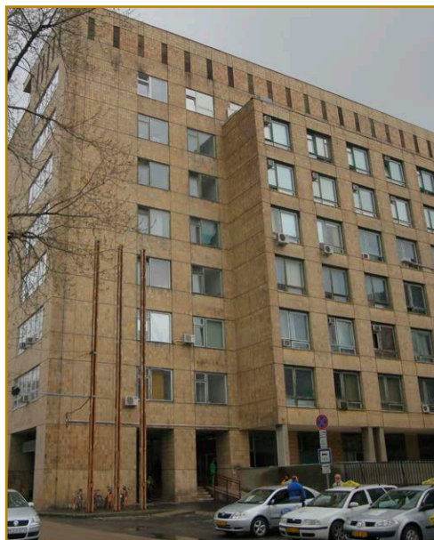
A 400-ágyas klinika épülete
